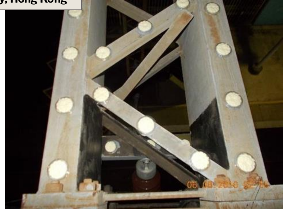
2 Bird Free am Signalbrücke angebracht, August 2016
